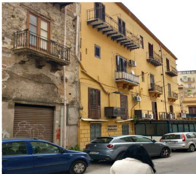
Figura 14. Ex ospedale dei tisici, retrospetto: la metà reintonacata fortunatamente ha salvaguardando le mensole di supporto ai balconi in aggetto.
