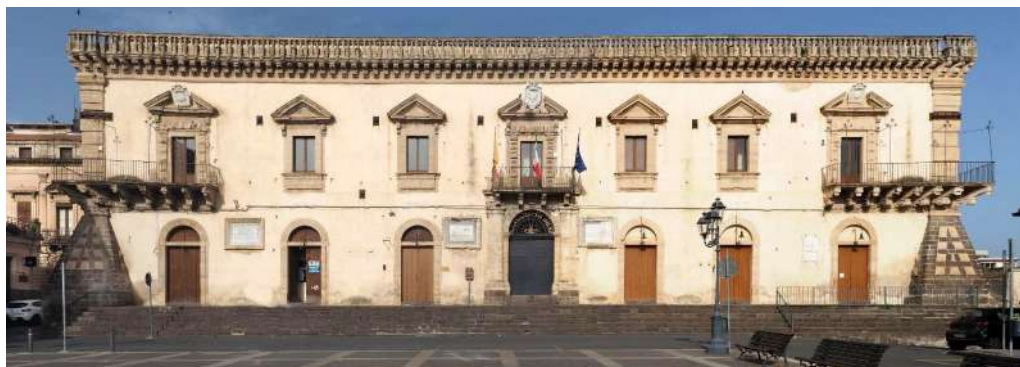
Figura 2. Facciata Palazzo Gravina-Cruyllas, attuale sede del Comune di Francofonte. Ph. C. Gaudio.
