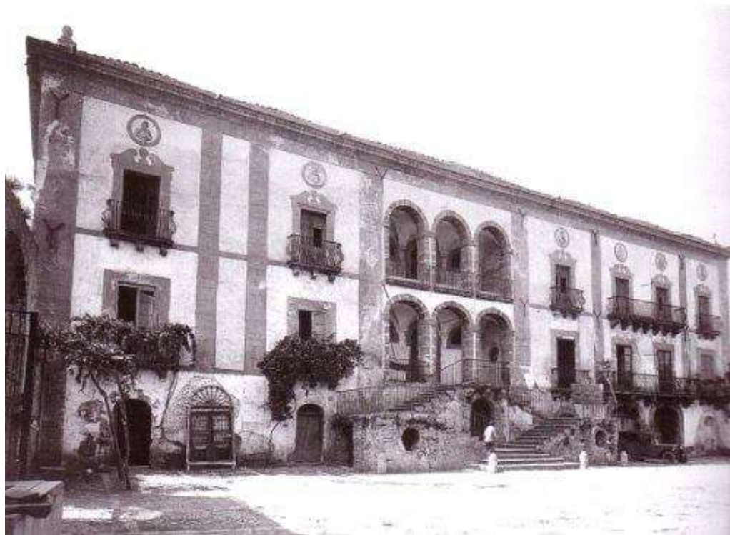
Figura 15. Villa Perez-Distefano demolita per la realizzazione dell'aeroporto. Facciata piatta scompartita da lesene, definita in alto da un cornicione aggettante. Non è simmetricamente suddivisa. La parte "centrale" è caratterizzata da un porticato di accesso con loggiato superiore. Scalonetto a tenaglia con due rampe. Da notare i balconi con un piccolo aggetto.
