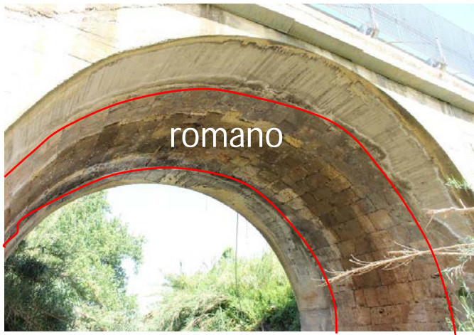
Figura 29. Il ponte Camei a Villabate chiuso sui due lati da due archi in c.c.a.
