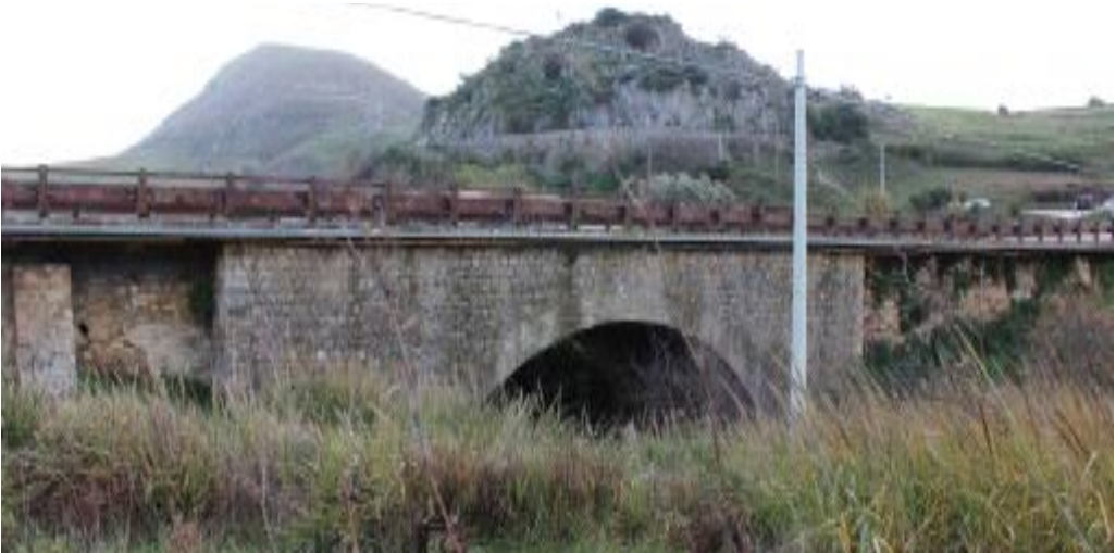
Figura 25. Ponte Cameri alle Terme di Cefalà Diana inglobato tra strutture più moderne.
