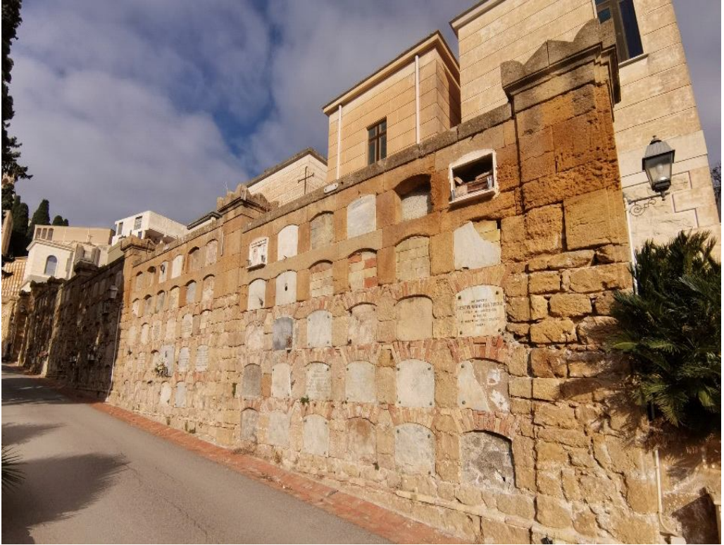
Figura 16. I colombari realizzati lungo il lato settentrionale dei campi di inumazione. Sono evidenti le volte in laterizio dei loculi nei primi tre registri originariamente costruiti. In un secondo momento venne realizzata una superfetazione con l'aggiunta di altri due registri (foto L. Torregrossa).
